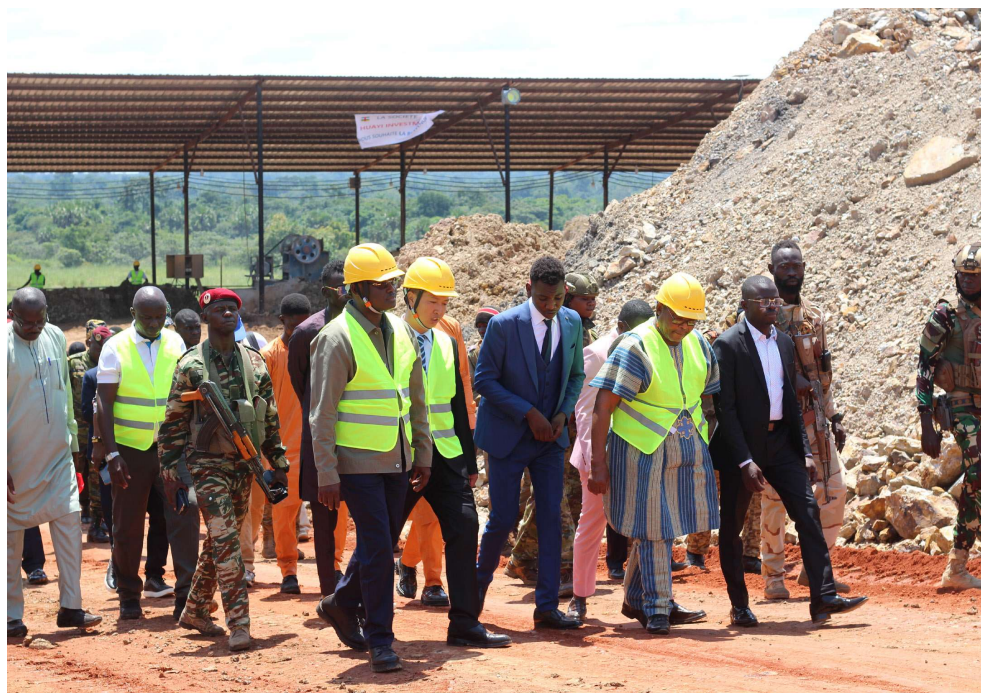
Descente du Ministre Rufin BENAM accompagné de son staff technique et des partenaires sur un chantier minier.
